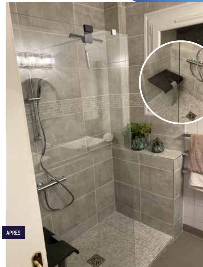
Projet : Remplacement d'une baignoire en douche Paroi fixe sérigraphiée + retour mobile vitré 30cm / Barre d'appui / Colonne de douche orientable / Receveur de douche antidérapant, extra-plat
