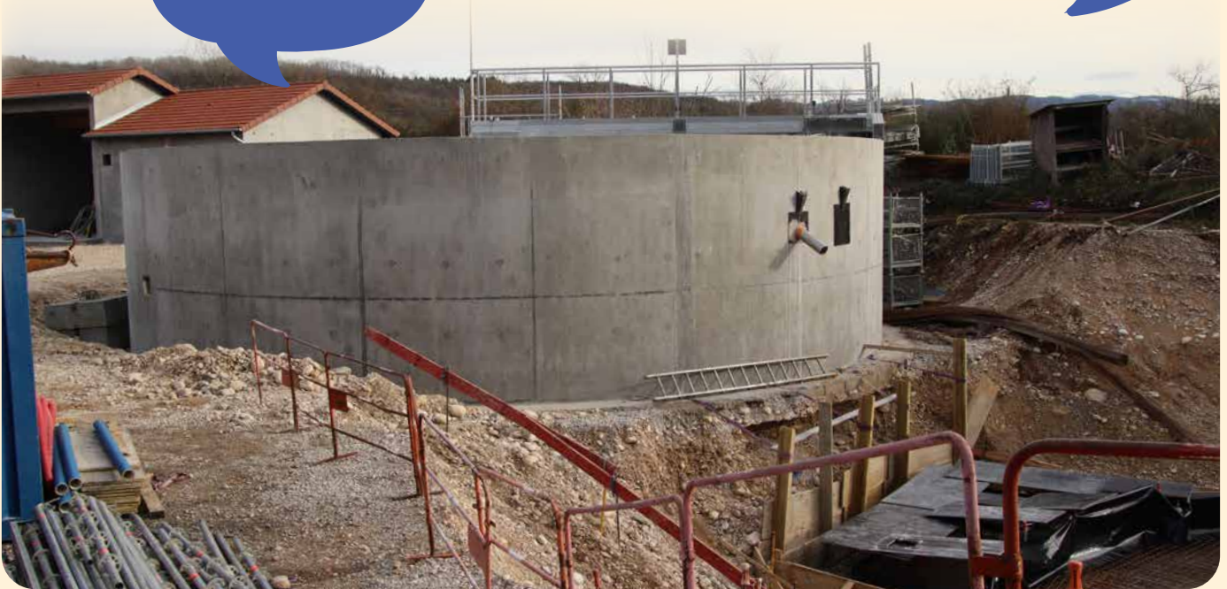
Travaux de la nouvelle station d'épuration à Thol
