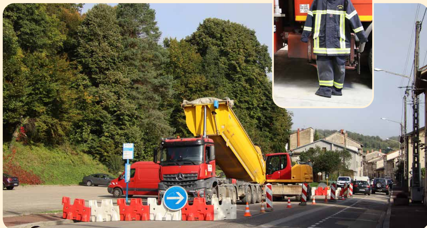
Réfection du passage piéton rue du Dr Hubert
