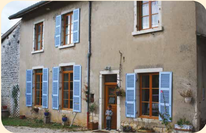
Le bâtiment actuel de l'école de Planches
