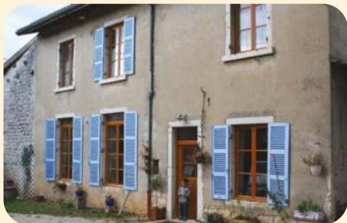
Le bâtiment actuel de l'école de Planches
